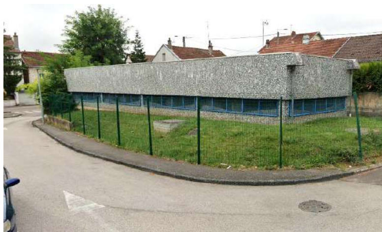
Figure 15 : bâtiment du puits de captage au droit du parking Lidl
