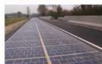
La route solaire photovoltaïque
