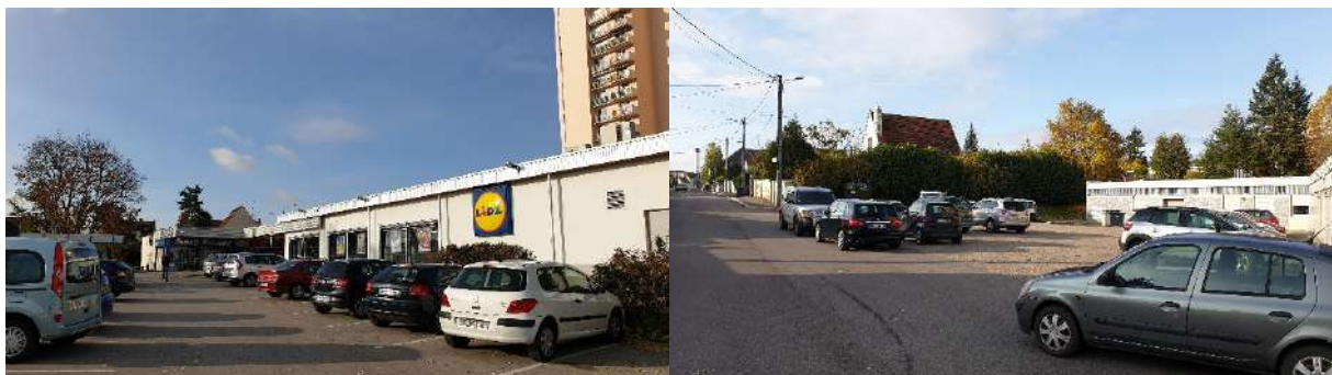
Figure 41 : parking de Lidl et parking à l'arrière du centre commercial
