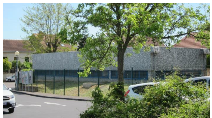
Présence d'un élément technique : la station de captage
